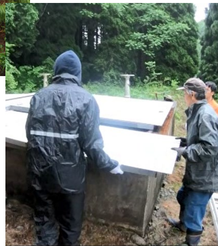
ろ過池の清掃作業 (T県N飲供)
